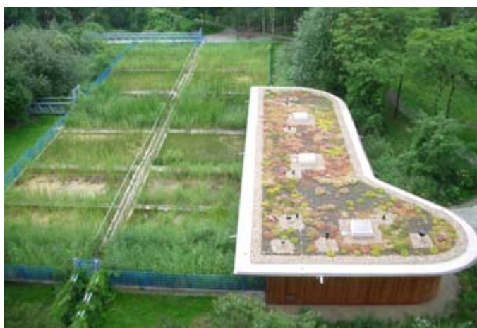
Block 6 nach der Optimierung/Umgestaltung 2006/2007
