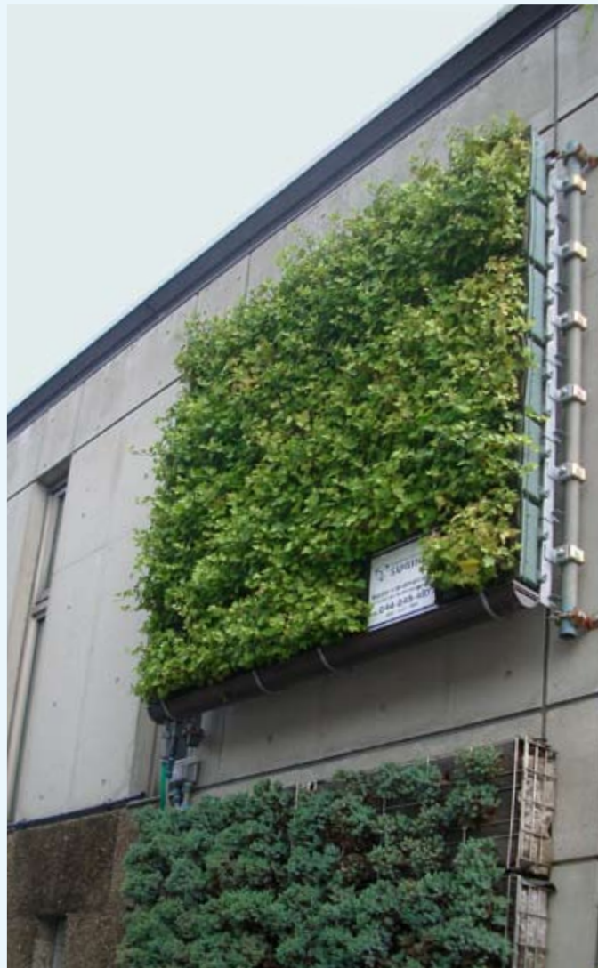
Testinstallation zur Fassadenbegrünung
