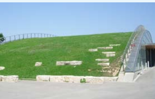
Dachbegrünung als „Freiflächenpotential“
