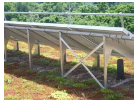
PV-Anlage auf extensivem Gründach als gelungene Synergie
