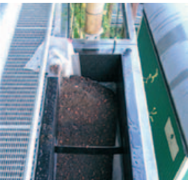
Pflanzkübel mit Substrat an der Fassade
