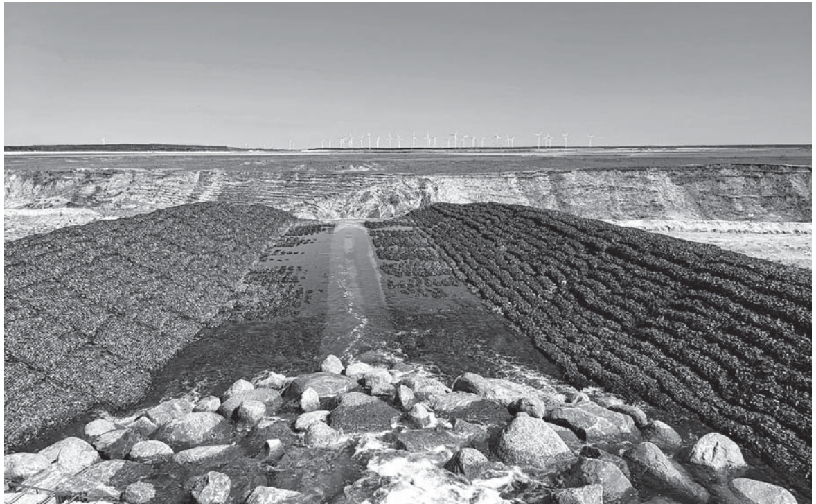
Einlaufbauwerk bei Lakoma zur Flutung des Ostsees
