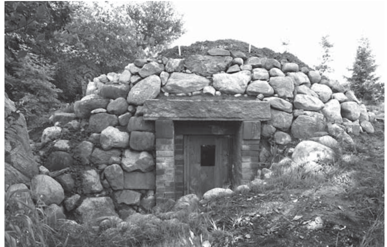
Ein Erdkeller ist im Sommer kühl und im Winter frostsicher.
